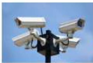
PENYIDRANAN CCTV GORJAP PERAJA-PERAJA PARKIR
